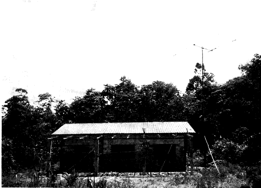
De in aanbouw zijnde vakantiewoning en shack van Pieter, 9M8CC.
